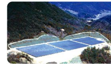
문경 SP 태양광발전소 [2.2MW] (2007 당시시공)
