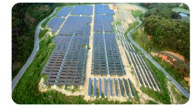
전주솔라 태양광발전소 [2MW] (2006 당시시공)
